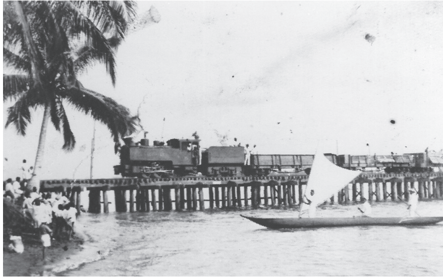
Fotografía 4. Entrada del tren de Tumaco, puente del Pindo.
