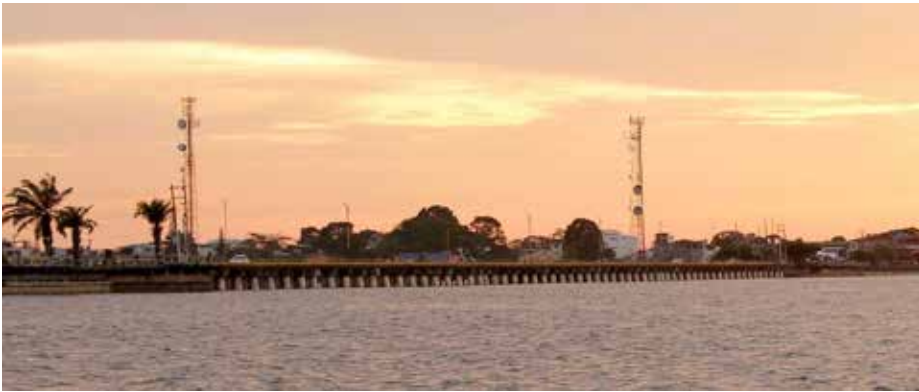
Fotografía No 2. Puente del Morro, Tumaco.
